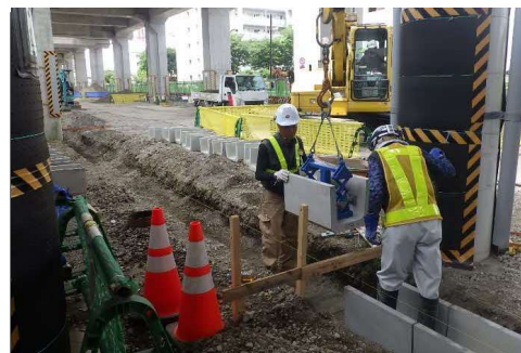
①西新井方 排水設備工事状況
