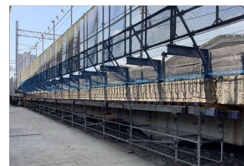
③谷塚方 既設高架橋復旧工事状況
