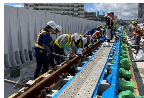
②駅付近 引上線軌道新設工事状況
