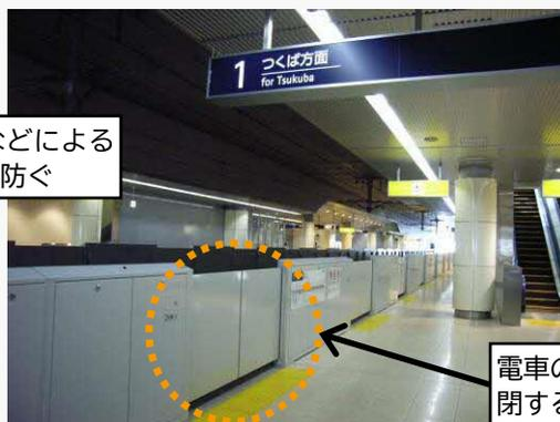
電車のドアと連動して、自動で開閉する
