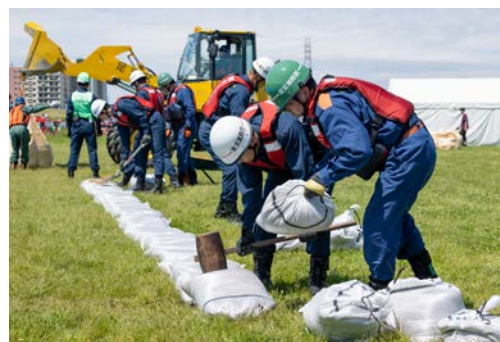
積み土のう工法（消防団）
