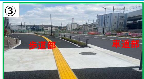
区画街路第14号線（街路部）道路整備工事実施箇所
