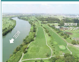
工事着手前(令和3年10月)
