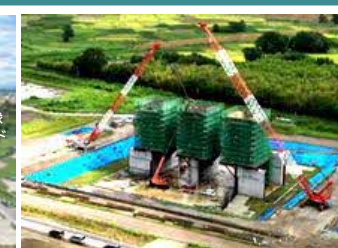
荒川第二調節池排水門施工中(令和6年8月)
