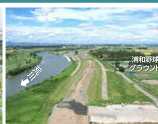
工事施工中(令和6年8月)
