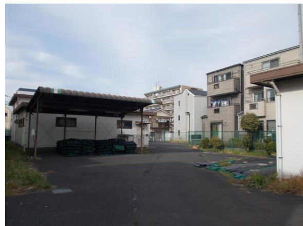
4 (旧) 綾瀬器材置場
