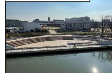
親水拠点部の完成状況
