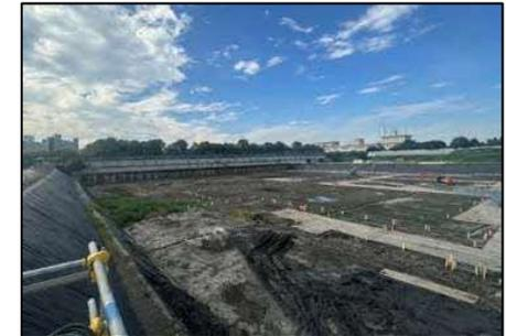
引き続き、第一期範囲において中川建設発生土改良プラント再構築その2工事(以下、その2工事、受注者:大成・西武建設共同企業体)を行います。その2工事では、将来構築するプラントの覆蓋施設のうち、基礎杭と底版コンクリートを施工します。
