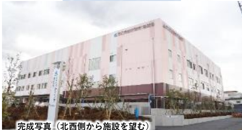
完成写真（北西側から施設を望む）
