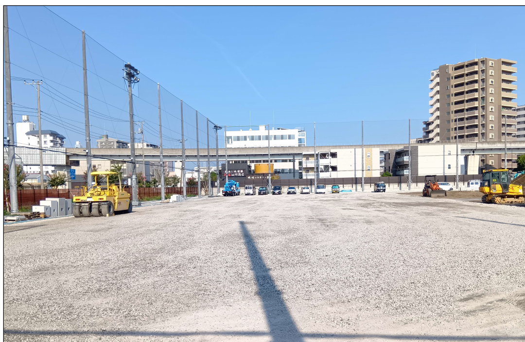
写真2 グラウンド整地の様子（令和7年8月26日撮影）
