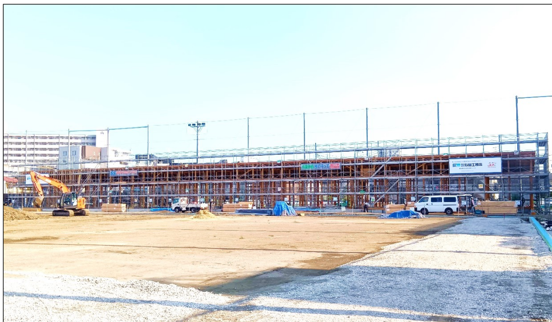
写真1 管理棟工事の様子（令和7年8月26日撮影）
