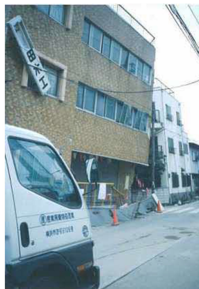
参考：阪神・淡路大震災の看板落下の被害
