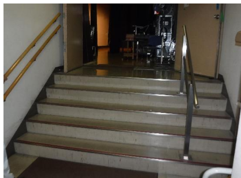
▲控室から舞台裏までの段差
