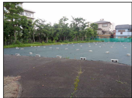
▲敷地内の樹木、飛散防止シート
