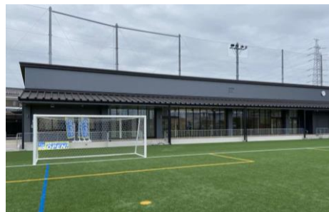
高野スポーツパーク管理棟 （ZEB Ready認証施設）
