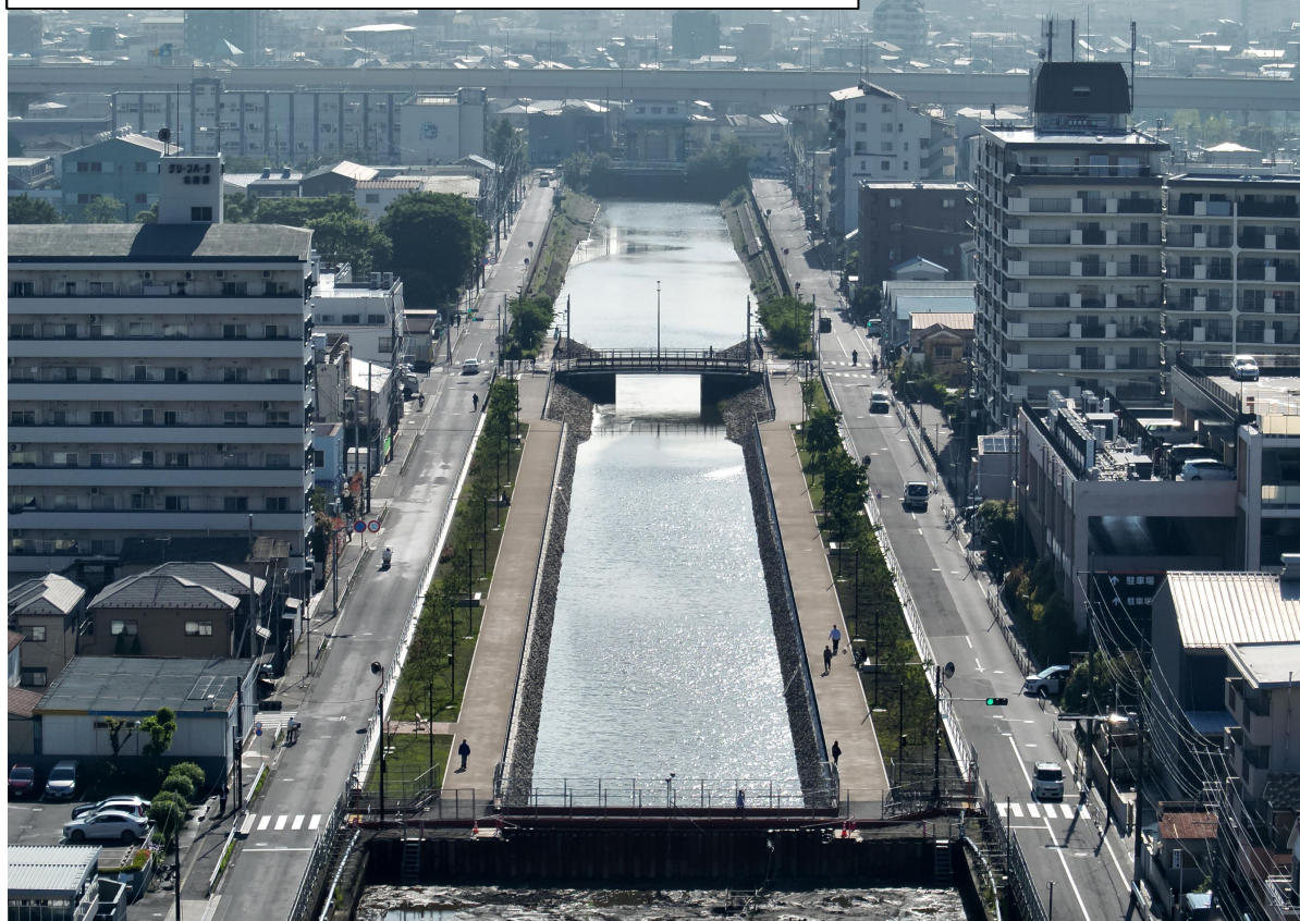
富士見歩道橋迂回路から雪見橋方向（西側）を撮影
