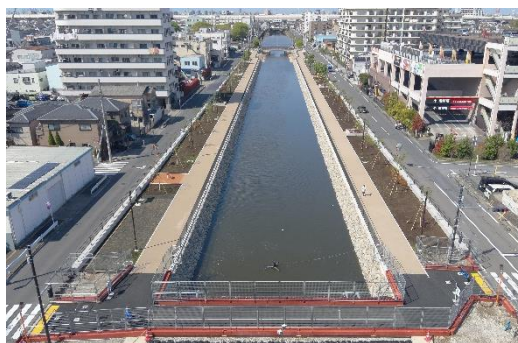
富士見歩道橋迂回路上空から雪見橋方向
