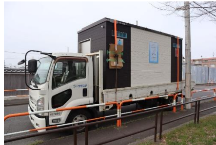
4 tトラックによる 移設の様子
