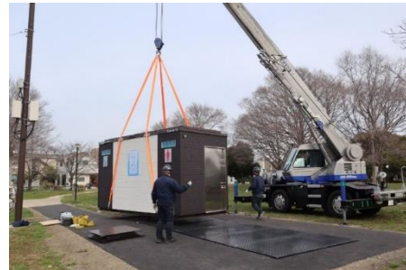
ラフタークレーン車 による吊り上げ
