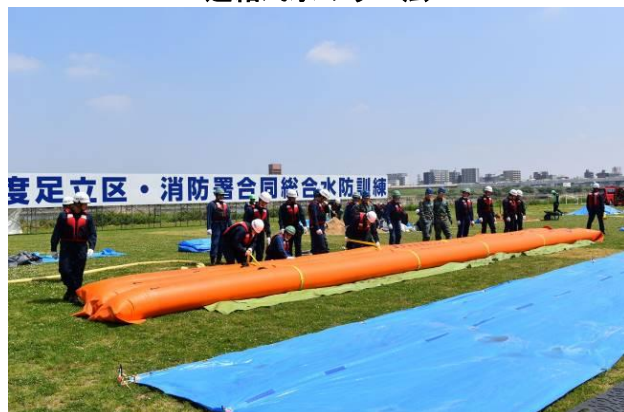
連結式水のう工法
