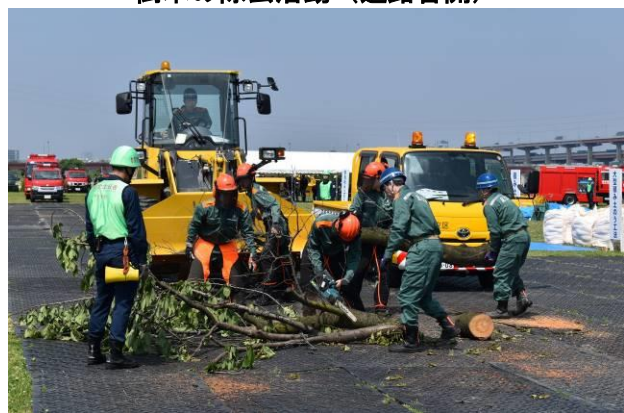
倒木の除去活動（道路啓開）
