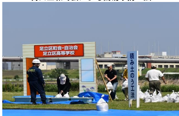
梅田正和町会による簡易水防工法
