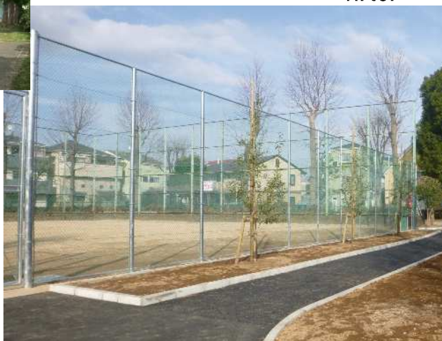
老朽化し建替えた青井公園のフェンス
